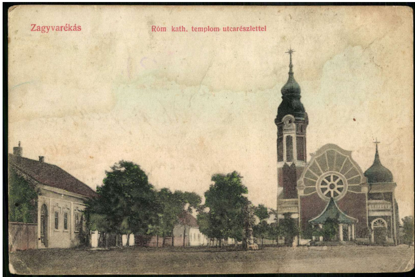
Zagyvarékasi római katolikus templom (Zagyvarékas 1906)
